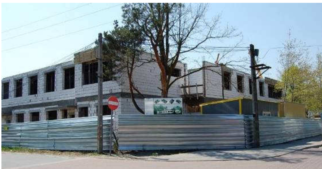
Przychodnia nr 1 w Sulejówku – w budowie
