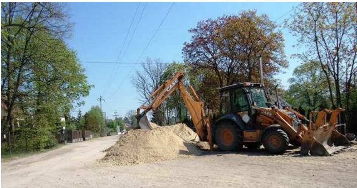
Ulica Sobieskiego – budowa kanalizacji i nawierzchni ulicznej
