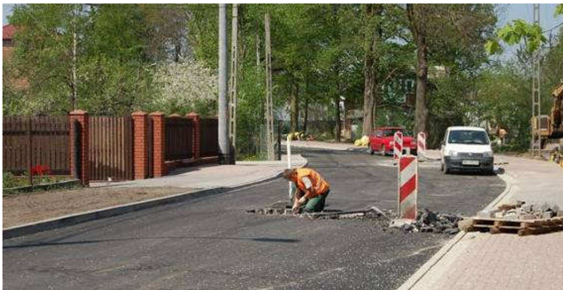
Ulica Okrzei – nowa nakładka asfaltowa
