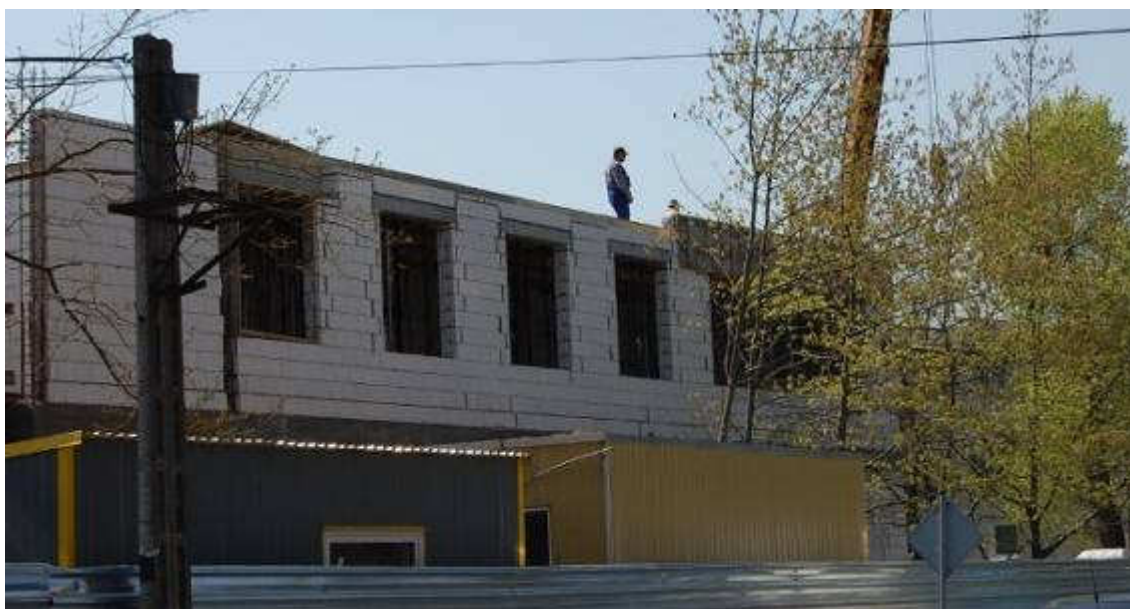
Przychodnia nr 1 w Sulejówku – w budowie
