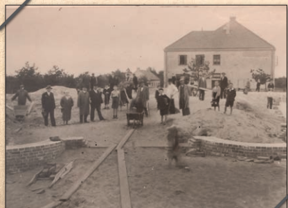
Budowa kościoła w Cechówce rozpoczęła się w 1934 r.
