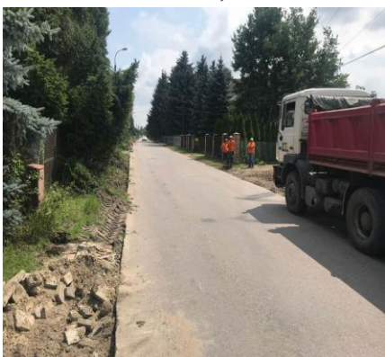
ul. Czynu Społecznego – przed przebudową
