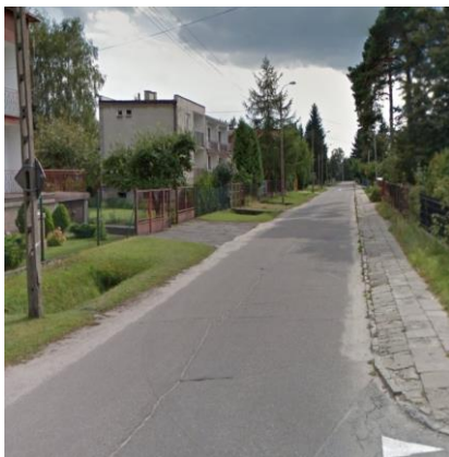
ul. Grabskiego – przed modernizacją
