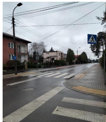
ul. Grabskiego – po modernizacji
