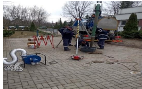
Czyszczenie zbiornika popłuczyn
