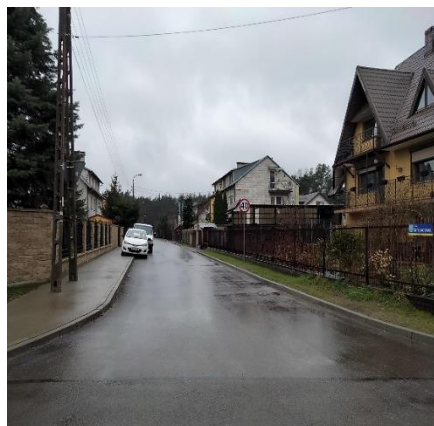
ul. Jałowcowa – po wykonanych pracach
