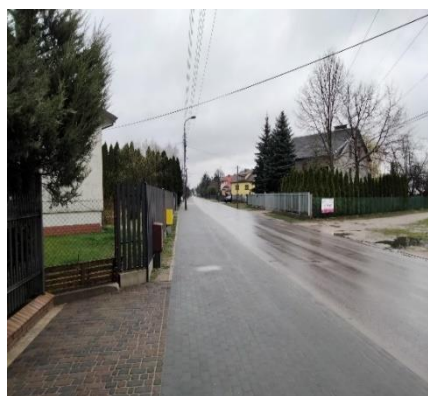
ul. Czynu Społecznego - po przebudowie
