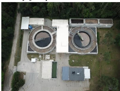
Widok z góry na oczyszczalnię ścieków
