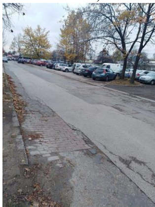
ul. Dworcowa – przed modernizacją
