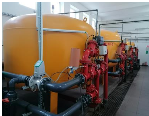
Hala filtrów SUW I.
