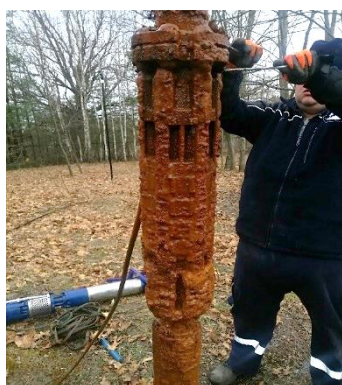
Fot. 9 - Wymiana pompy głębinowej – stara pompa wyjęta ze studni.
