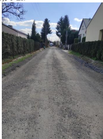
ulica Grunwaldzka po wykonaniu inwestycji
