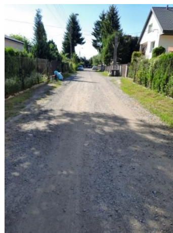
ulica Grunwaldzka przed inwestycją
