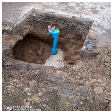
Wymiana hydrantu na sieci wodociągowej.
