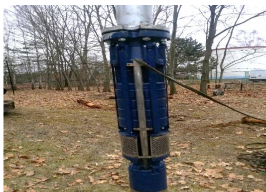
Fot. 10 – Wymiana pompy głębinowej – nowa pompa do zamontowania w studni.
