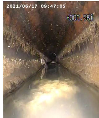
Kamerowanie sieci kanalizacji sanitarnej.
