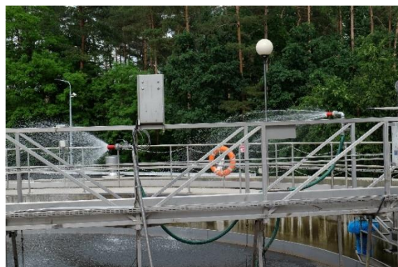
Spryskiwacze reaktora wtórnego.
