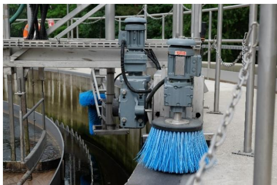
Szczotki czyszczące reaktor.
