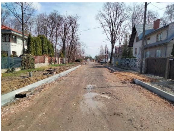
ul. Krakowska w trakcie trwania robót
