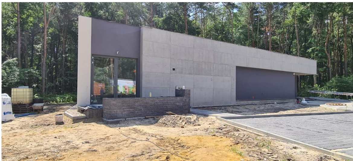
Budowa budynku biurowego MZWik w Sulejówku, ul. Okuniewska 2B.
