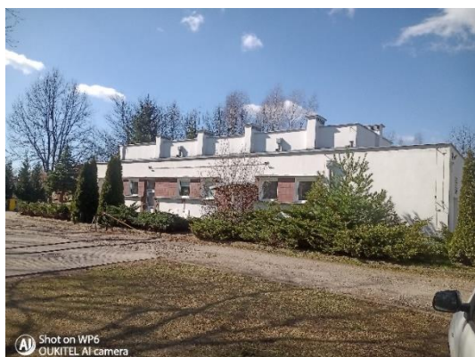
Fot. 1 – Budynek SUW I.
