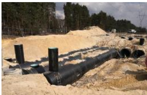
Retencyjne zbiorniki podziemne – w trakcie trwania robót
