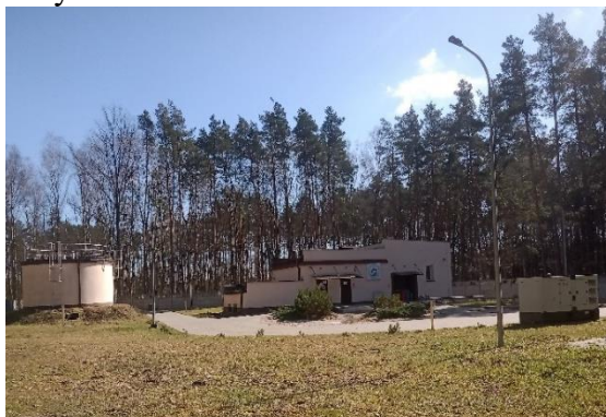
Fot. 4 – Budynek SUW II.
