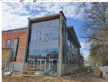
Basen od strony ul. Paderewskiego – wejście główne
