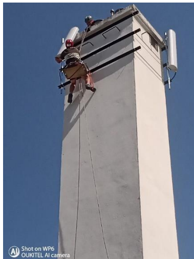
Montaż anteny do zdalnego odczytu wodomierzy.
