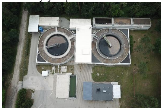
Widok z góry na oczyszczalnię ścieków.
