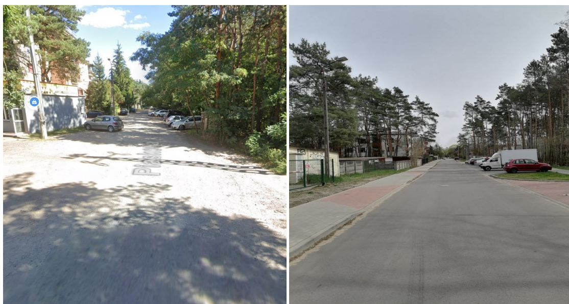
Zdjęcie 31. ul. Piaskowa przed i po przebudowie
