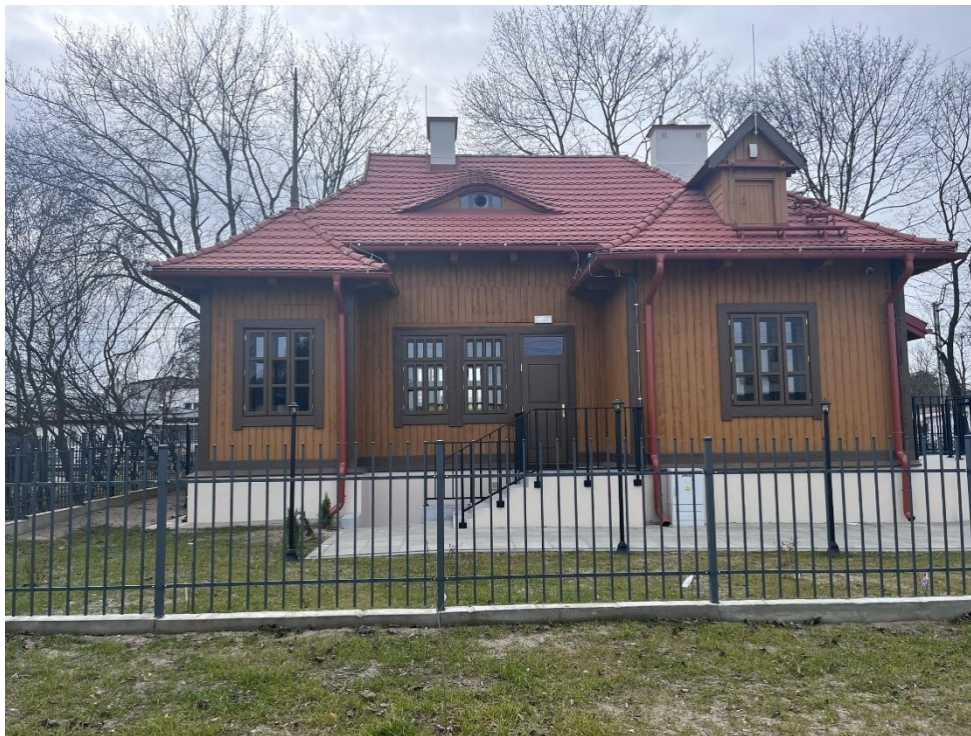
Zdjęcie 25. Budynek dworca po rewitalizacji
