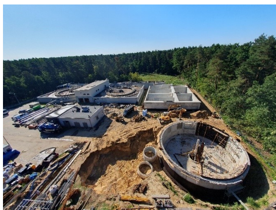
Zdjęcie 17. widok z góry na rozbudowę oczyszczalni ścieków.
