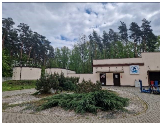
Zdjęcie 16. budynek SUW II
