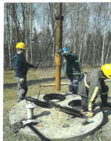
Fot. 9 – Wymiana pompy głębinowej
