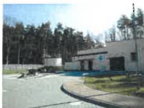
Fot. 5 – Budynek SUW II
