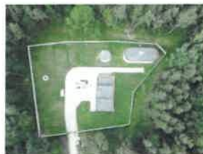
Fot. 6 – Widok z góry na SUW II
