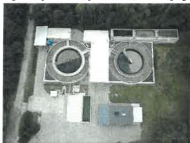
Fot. 13 – Widok z góry na oczyszczalnię ścieków
