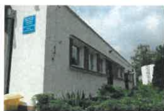
Fot. 1 – Budynek SUW I
