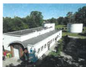
Fot. 2 – Widok z góry na SUW I
