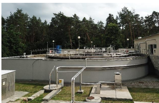
Reaktor oczyszczalni ścieków
