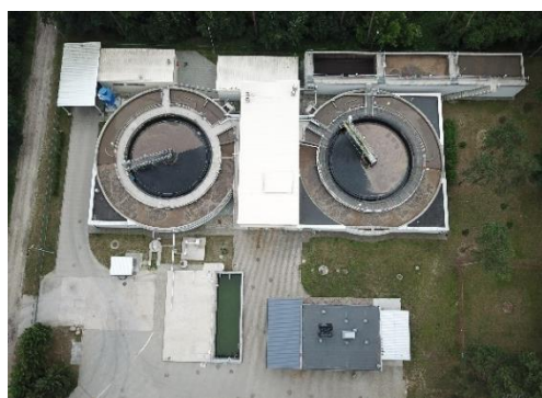
Widok z góry na oczyszczalnię ścieków
