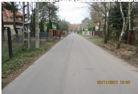
Nakładka asfaltowa na ul. Wiśniowej
