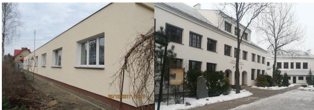
Termomodernizacja: budynku komunalnego i Szkoły Podstawowej nr 3
